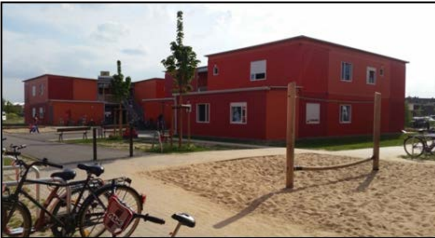
Beispiel für Systembauweise in Bremen
