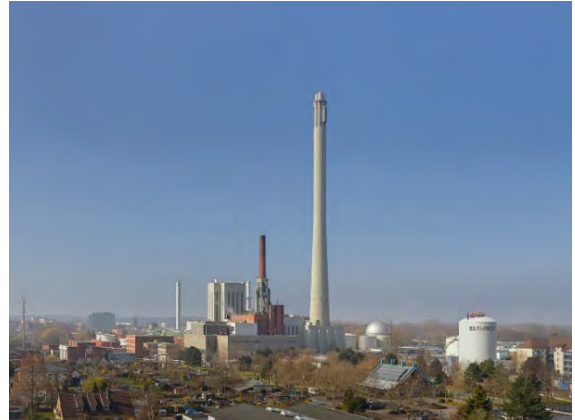
Abbildung 17: HKW-Mitte Quelle: BS|ENERGY
