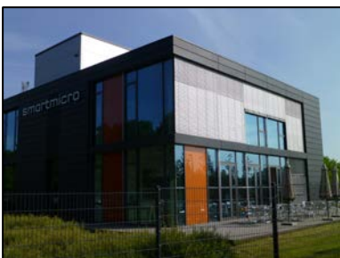
Abbildung 17: Neuansiedlung im Baugebiet Kralenriede-Ost
