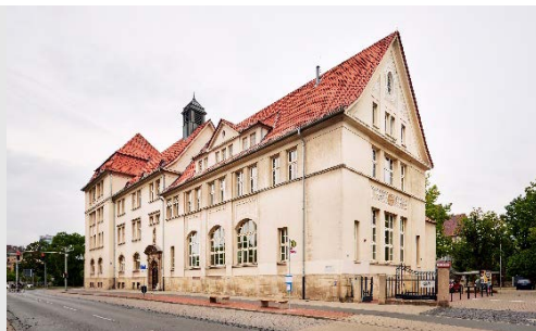
Denkmalgeschützte J.-F.-Kennedy Schule Braunschweig
