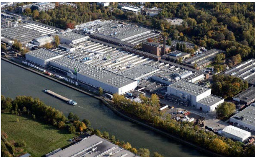
► Ausbau Batteriewerk Hannover Neubau von 5 Hallenkomplexen
