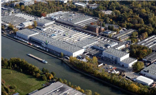
► Clarios - Ausbau AGM-Produktion „Werk Hannover“
