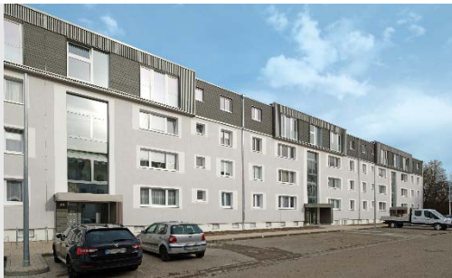
▶ „Bradleystraße“ in Neu-Ulm MOD/INST / Aufstockung
