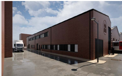
Hamburger Hochbahn Hauptwerkstatt HH-Barmbek BBA _ Neubau Halle 1 und 2c
