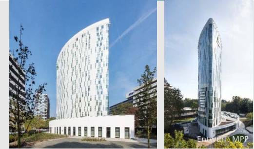
Hotelgebäude CITY NORD Hamburg Neubau
