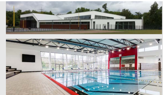
Sportbad Thurmfeld in Essen Neubau
