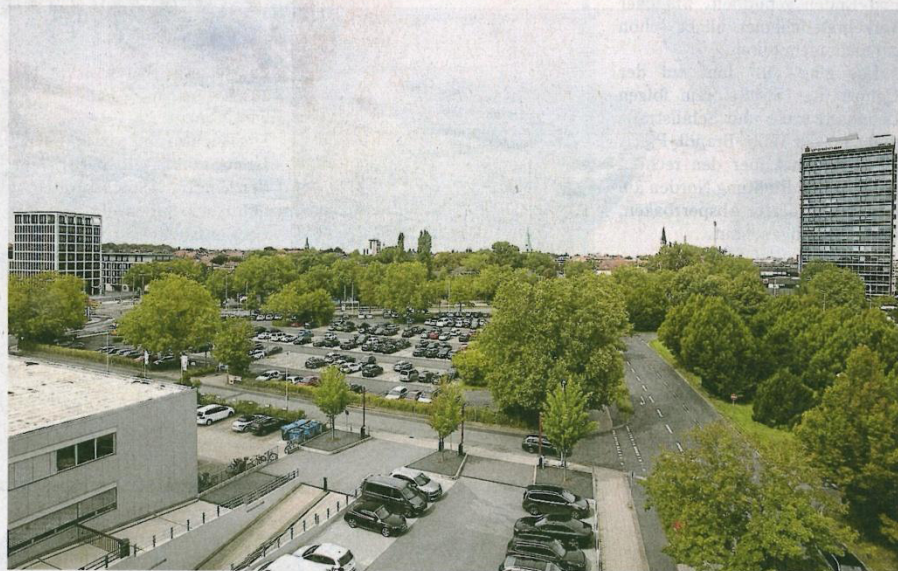
Blick vom Voets-Hochhaus hinab auf die Parkplatzflächen am Holztor und auf den Europaplatz, wo eine Nachverdichtung mit Bürogebäuden möglich wäre.
