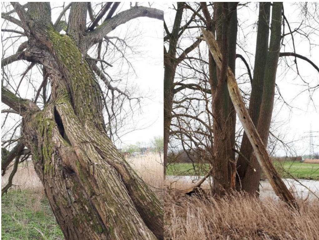
Abb. 2-25: Links: Ältere Baumweide mit tiefer Spalte und Ausfaltungen im Stammbereich (ID 118, km 11+980); rechts: Vollständig abgestorbener und umgestürzter Stamm mit Vielzahl von Spechtlöchern (ID 37, km 13+050).
