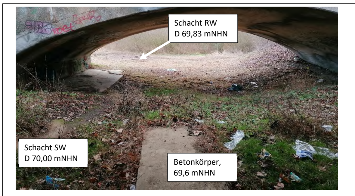
Abbildung 5: Schachtbauwerke Schmutzwasser und Betonkörper unter der Brücke Bienroder Weg ,
