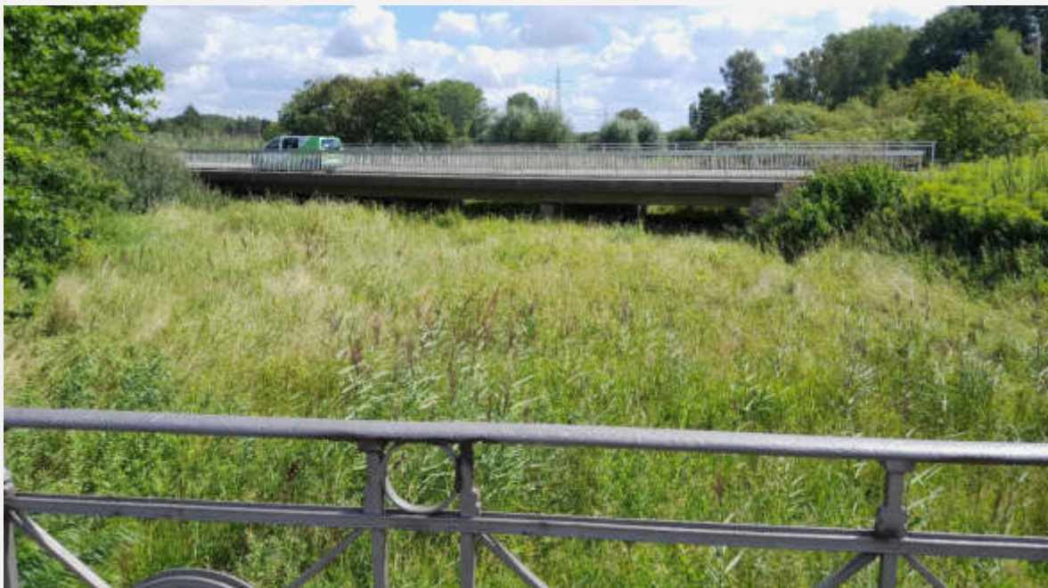
Foto 6 Bereich der geplanten Flutmulde M23 Hier wurde die Bohrung KRB-10 abgeteuft. Foto vom 10.08.2023.
