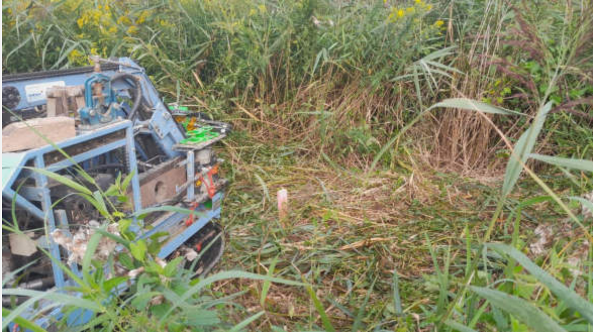
Foto 9 Bohrung im Bereich des geplanten Stillgewässers M42 Aufnahme vom 04.08.2023.
